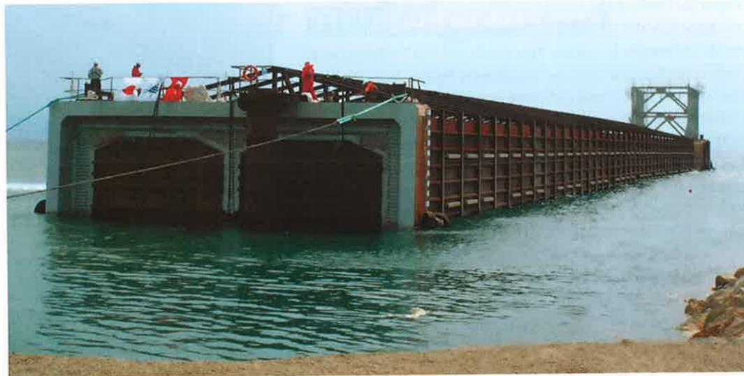
Elf Stahlbetonsegmente wurden für die Tunnelröhre im Bosphorus im Dock und schwimmend erstellt.
