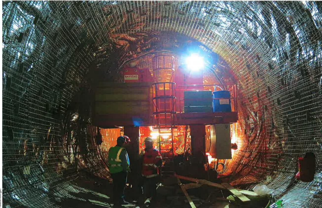
Der U-Bahn-Tunnel unter der Favoritenstraße, die Bewehrung steht und wartet auf die Schalung und Beton.
